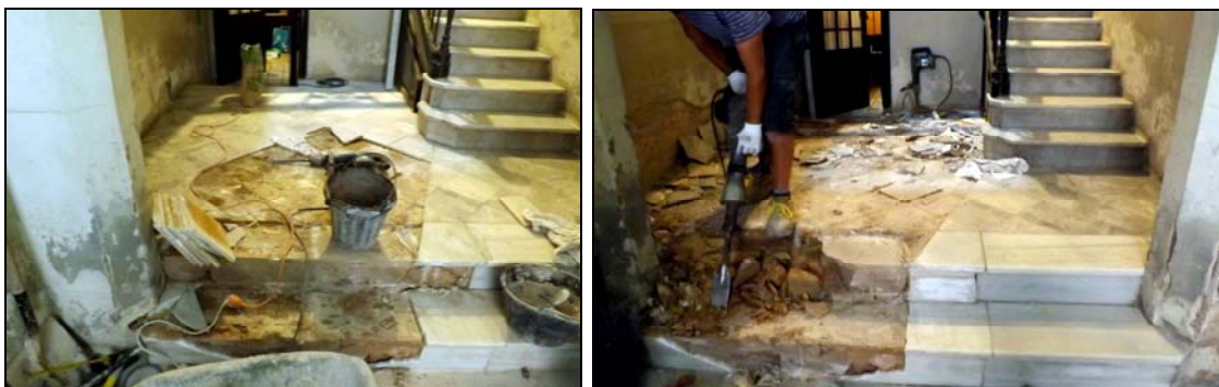
Desmuntatge del paviment (u.e. 100) i dels graons (u.e. 101)
