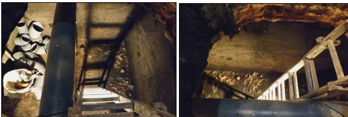
Dues vistes de l'interior de la fossa sèptica u.e. 104
