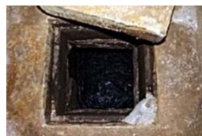
24) Vista interior fossa.JPG
