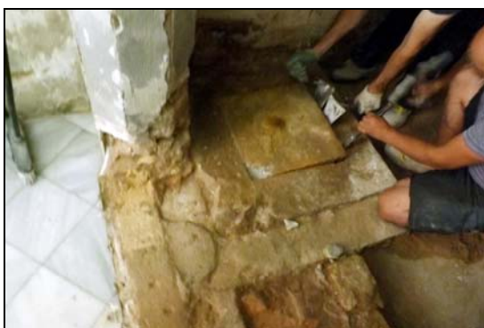
Moment en que es va aixecar la tapa i vista de l'interior de la fossa sèptica
