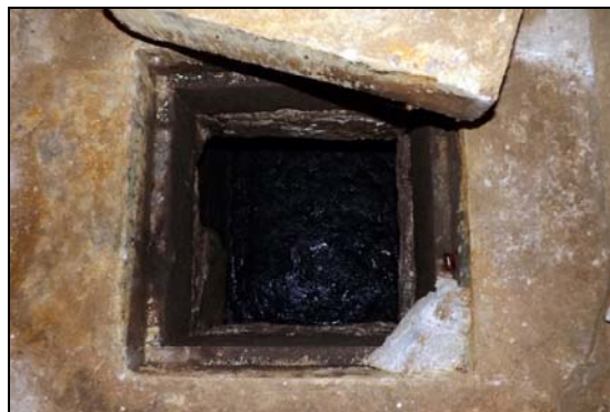
Moment en que es va aixecar la tapa i vista de l'interior de la fossa sèptica
