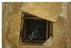
23) Vista interior fossa.jpg
