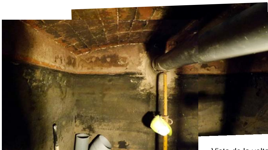
Vista de la volta de maons de la fossa sèptica
